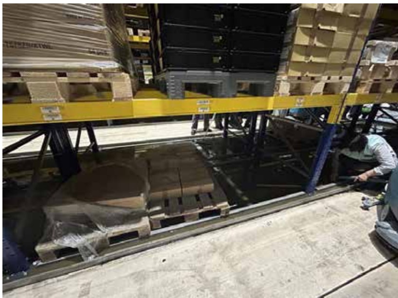
Fig.08 | Incidente com sprinklers na zona do armazém da logística Brg102 em 2025
